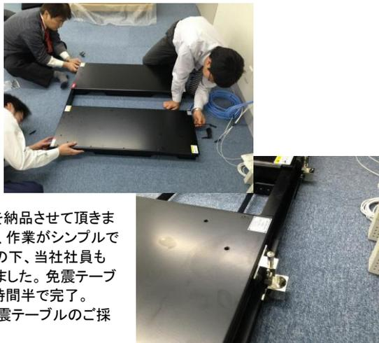
免震テーブル (THK TSD型) を納品させて頂きました。今回の設置条件では、作業がシンプルであったため、THKさん同行の下、当社社員も設置作業にあたらせて頂きました。免震テーブルの組立～設置まで、約1時間半で完了。サーバー設置の際には、免震テーブルのご採用を是非ご検討ください。
